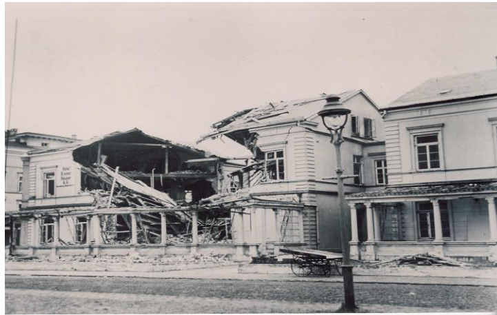
Zerstörtes Haus der Hotelanlage (1944)
